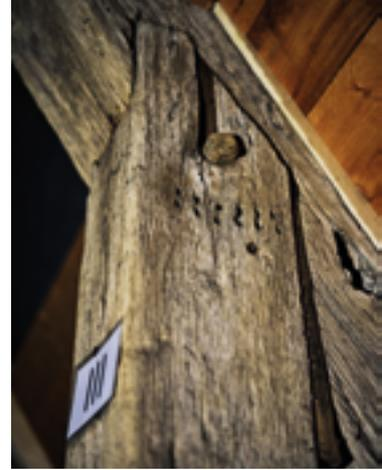
*Details des fast 800 Jahre alten Dachstuhls; rechts im Bild sind am Balken die alten Abbundzeichen zu erkennen*
