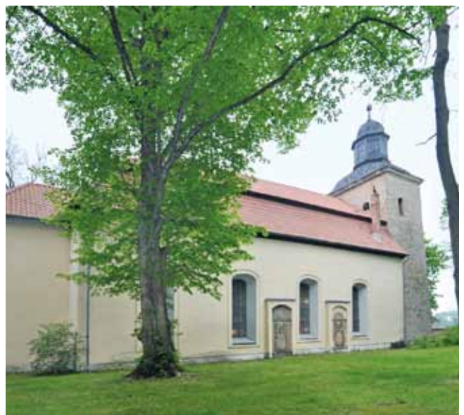
Gnadenkirche Giersleben, Förderung 2020
